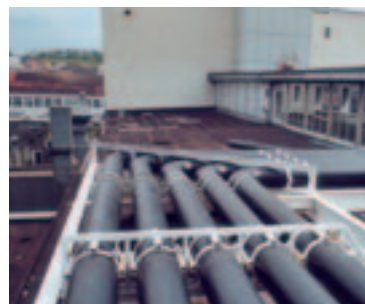
Вытяжной трубопровод из ПЭ-EL
