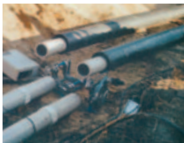
Подготовка к сварке в системе двойных труб
