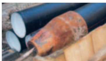
Замена коэкструдированными трубами ПЭ 80, Релайнинг
