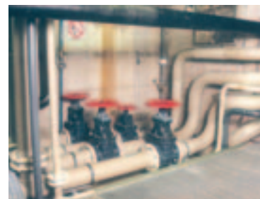
Трубопроводы из ПП в плавательном бассейне
